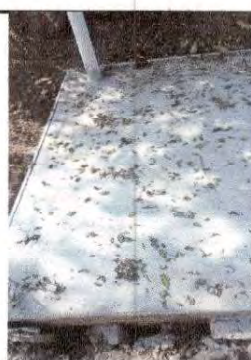
Foto 12: LIMPIEZA DE FOSA SEPTICA, MODULO DE BAÑOS
