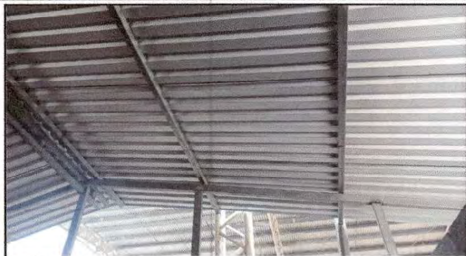
Foto 2: SUSTITUCION DE ESTRUCTURA DE MADERA, POR METAL, AREA DE COCINA
