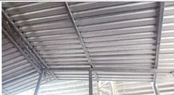
Foto 1: Sustitución de lámina, por lámina troquelada aluzinc calibre 26. En el modulo de la cocina
