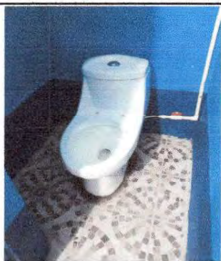
Foto 7: SUSTITUCION DE INODORO (INCLUYE INSTALACION Y MATERIALES) EN EL MODULOS DE BAÑOS
