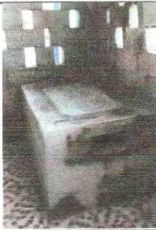
Foto 11: SUSTITUCION DE ESTUFA RURAL (COMPLETO) CHIMENEA Y PLANCHA DE METAL, MODULO DE COCINA
