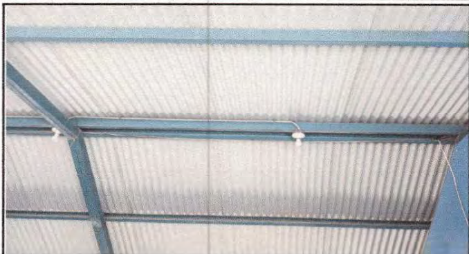
Foto 8: SUSTITUCION DE FOCOS AHORRADORES, Y PLAFONERAS, EN TODOS LOS MODULOS
