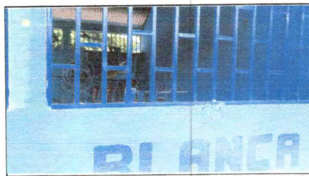
Foto 4: SUSTITUCION DE BALCONES DE METAL, EN LOS MODULOS DE LA COCINA Y AULAS
