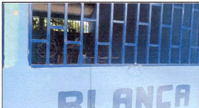
Foto 4: SUSTITUCION DE BALCONES DE METAL, EN LOS MODULOS DE LA COCINA Y AULAS
