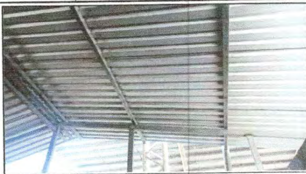
Foto 2: SUSTITUCION DE ESTRUCTURA DE MADERA, POR METAL, AREA DE COCINA
