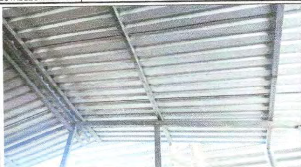
Foto1: Sustrucción de lámina, por lámina troquelada aluzinc calibre 26. En el modulo de la cocina
