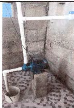
Foto 9: SUSTITUCION DE BOMBA DE AGUA, MODULO DE COCINA
