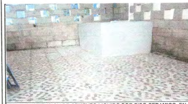
Foto 5: SUSTITUCION DE CEMENTO LIQUIDO POR PISO CERAMICO, EN LOS MODULOS DE LA COCINA Y AULAS
