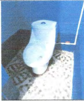
Foto 7: SUSTITUCION DE INODORO (INCLUYE INSTALACION Y MATERIALES) EN EL MODULOS DE BAÑOS
