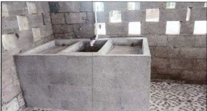
Foto 10: SUSTITUCION DE PILA DE CEMENTO, (TANQUE), MODULO DE COCINA
